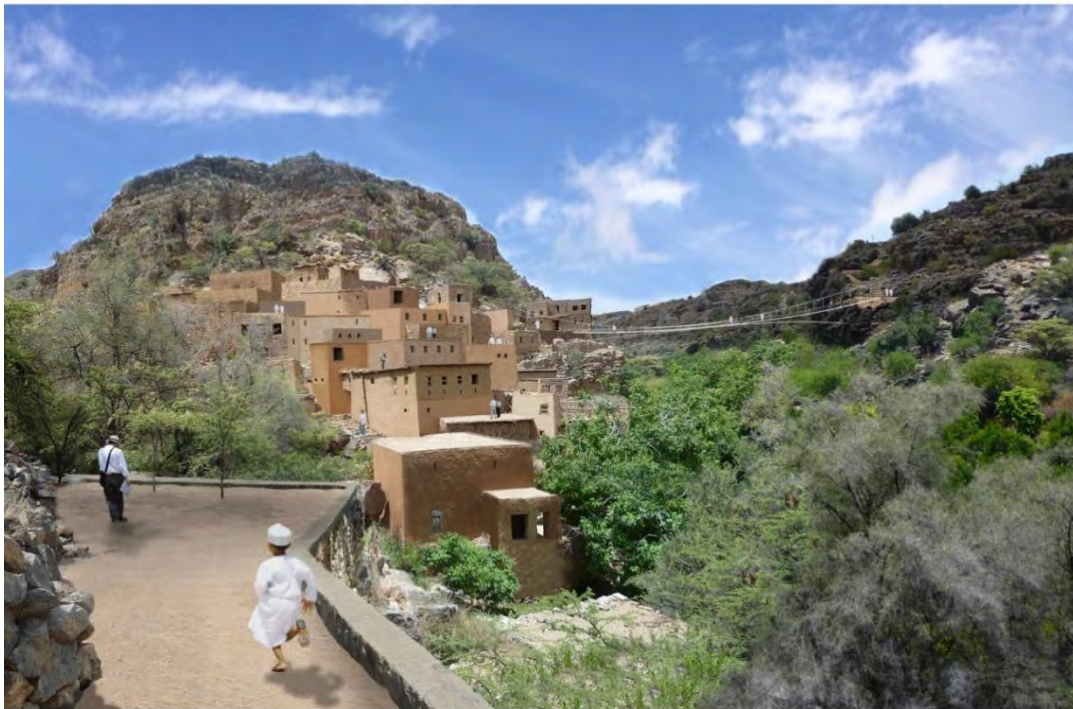
Fig.6 Vista del Asentamiento Norte. Puente de Acceso, pasos peatonales, terrazas y edificios rehabilitados.
