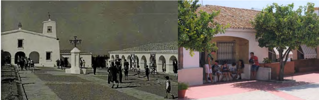
Figuras 15. Aldea Minas de Herrerías. Puebla de Guzmán (Huelva). Proyecto Alejandro Herrero. (AMH_FAHA, 1952). Figuras 16. (Dcha.). Porche de acceso con área de convivencia (conservada) en 50 Viviendas en Ayamonte. (Autores 2017).
